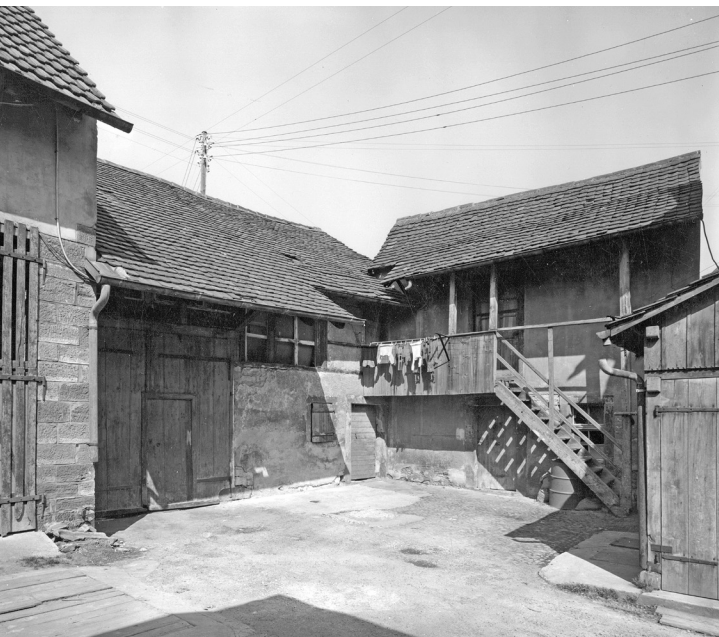
35. Hinterhof von Schmiedgasse 19 mit Scheune und Stall sowie Nebentrakt gegen das Webergässchen (um 1964). Am linken Rand das Wirtschaftsgebäude von Schmiedgasse 15.
