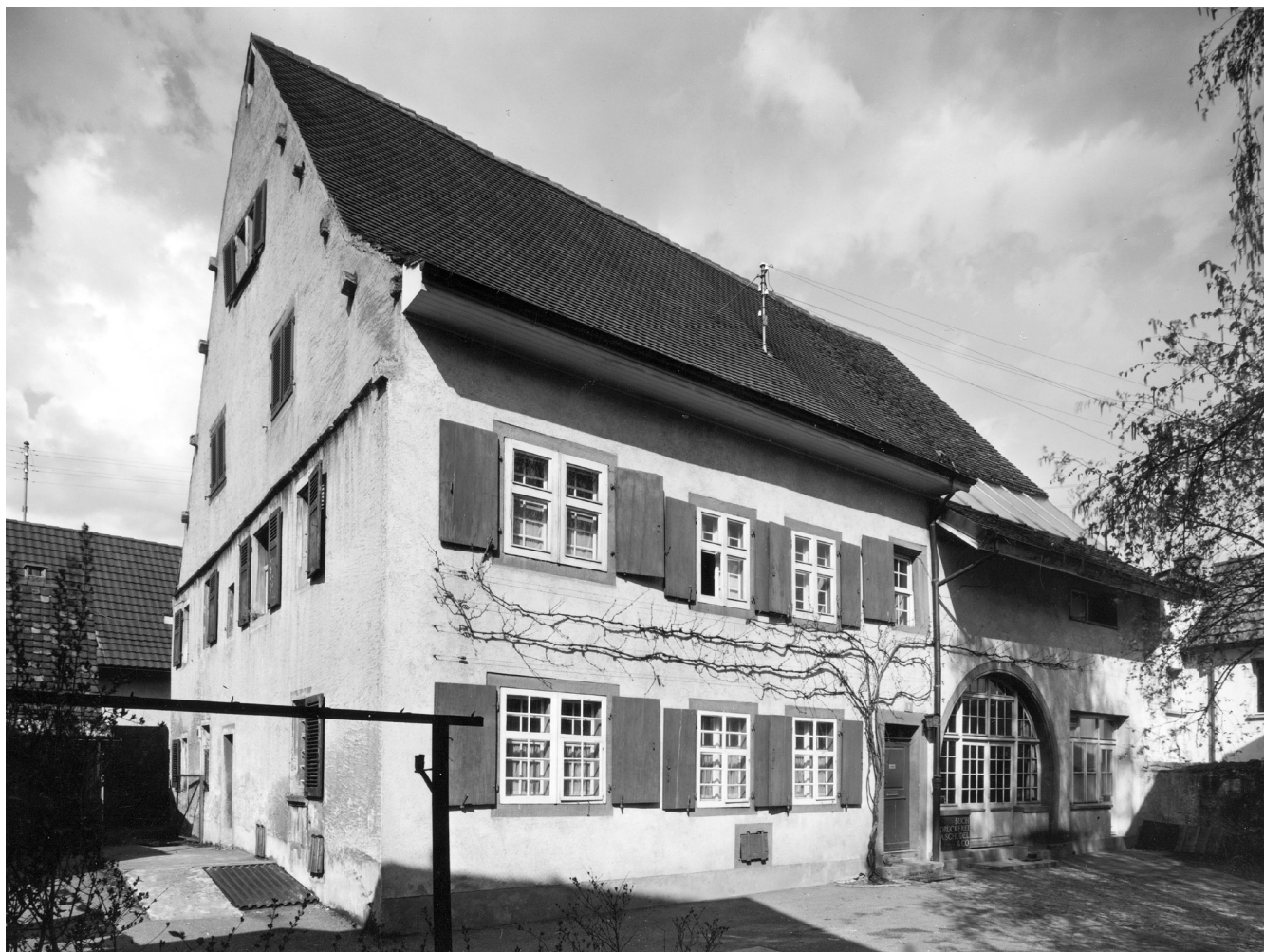
22. Ehemaliges Bauernhaus Schmiedgasse 9 (1964).
