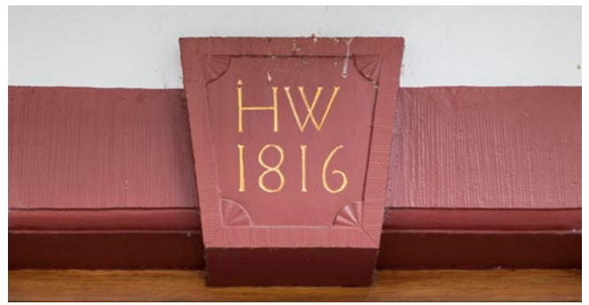
167. Türsturz des nach dem Brand von 1816 neu erbauten Hauses mit den Initialen des Erbauers J[ohannes] H[annes] W[enk] (J und H in Ligatur), 1952 auf die Seite Frühmesswegli versetzt (2017).
