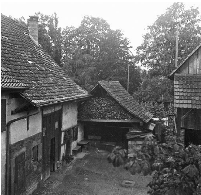
161. Hofseite von Baselstrasse 40 mit angebautem Schopf (vor 1949).
