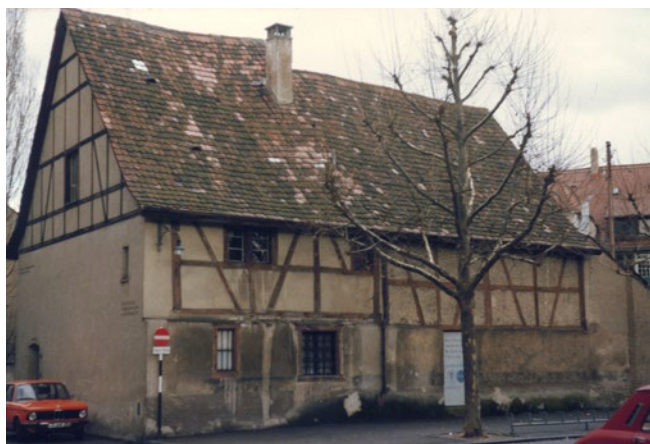
163. Haus Baselstrasse 42 nach dem Abbruch von Baselstrasse 40 (1975/76).
