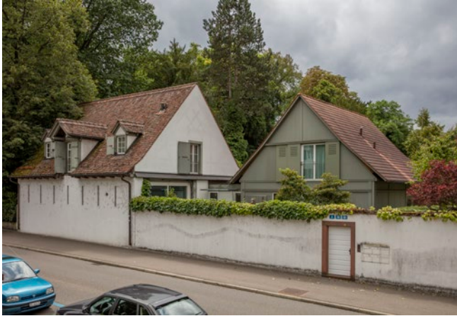
88. Gebäude Bettingerstrasse 10 und 12 (ehemals Orangerie), in Abb. 89 ganz links im Bild (2017).
