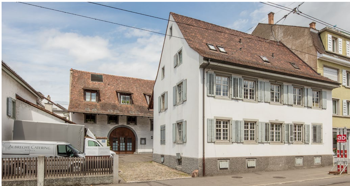
28. Das restaurierte Haus Baselstrasse 15 (2017).
