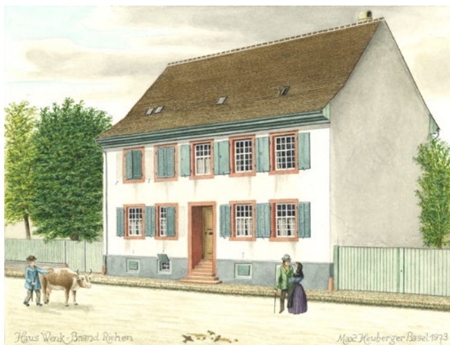
29. Haus Wenk-Brand um 1880. Die Haustüre mit davor liegender Treppe liegt noch in der Mitte des Gebäudes. Aquarell signiert und datiert «Max Heuberger Basel 1973».
