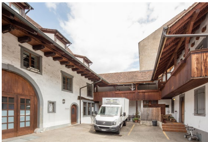
30. Das mehrfach umgebaute Hintergebäude mit Laube, rechts Rückfassade des Vorderhauses (2017).
